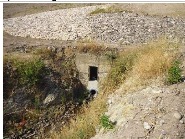
Bottom outlet exterior
